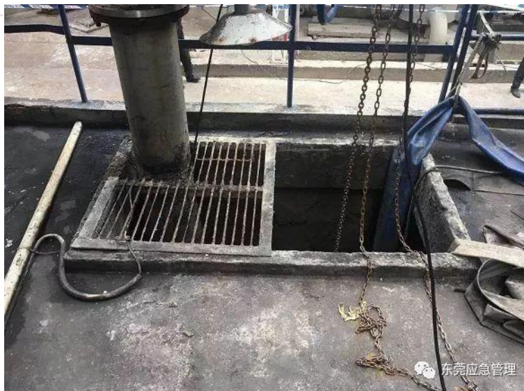
涉事污水调节池
